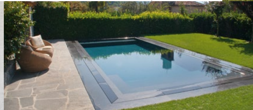
Freibad mit bauseits steinüberdeckter Überlaufrinne.
