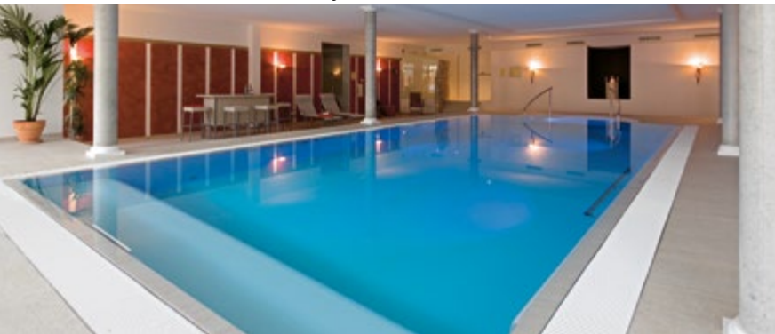
Hotelbad mit Überlaufrinne aus GFK.
